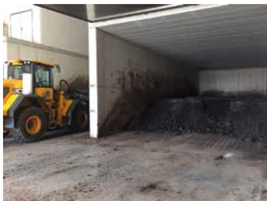
Tunnel voor biothermische droging bij Biogas De Biezen
